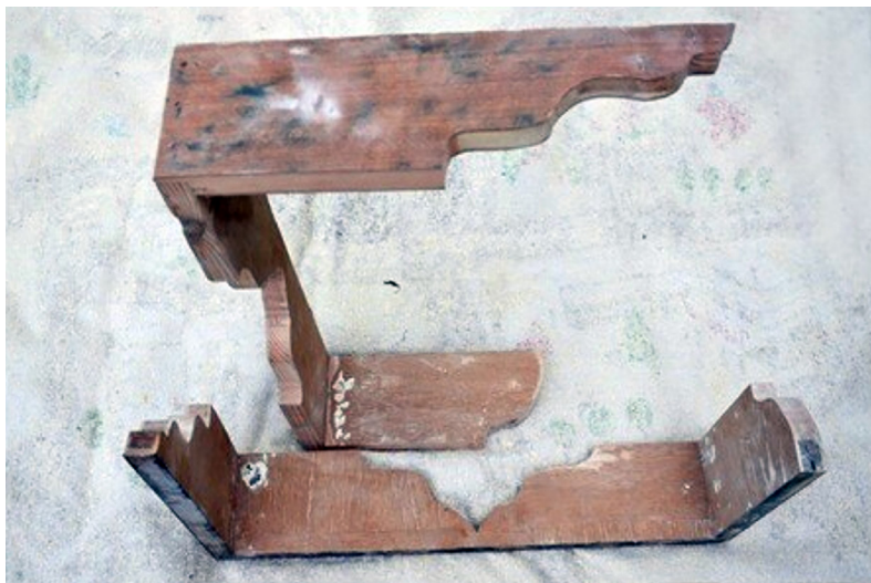
Ryc. 12. Podnózek, stan po wycięciu nowych profili zgodnych z zatwierdzonym projektem
