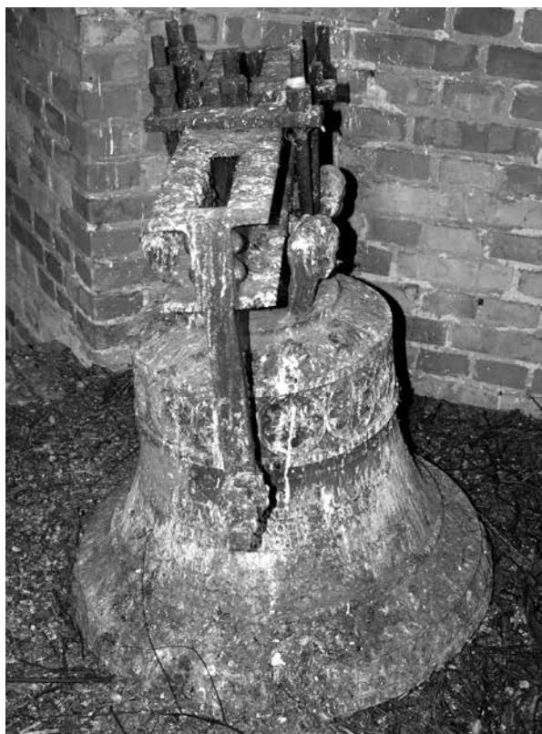
Głuchowo (powiat sulęciński) – dzwon porzucony na jednej z kondygnacji wieży (obecnie – 2014 r. – grozi zarwaniem) oraz ptasie odchody
