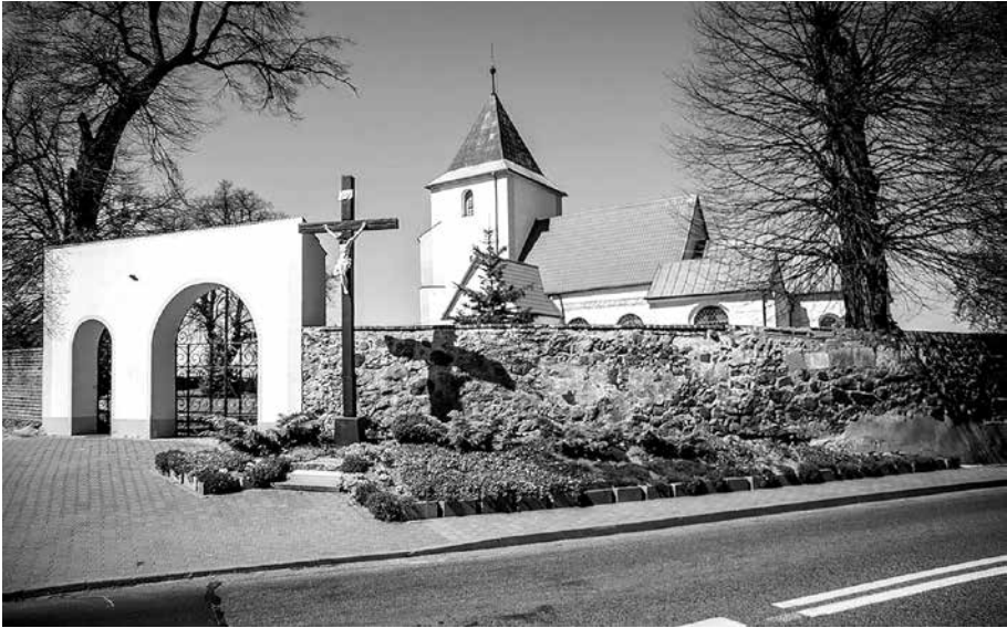
Ryc. 3. Fragment ogrodzenia okalającego kościół parafialny pw. Bożego Ciała w Brzegu Głogowskim w powiecie głogowskim
