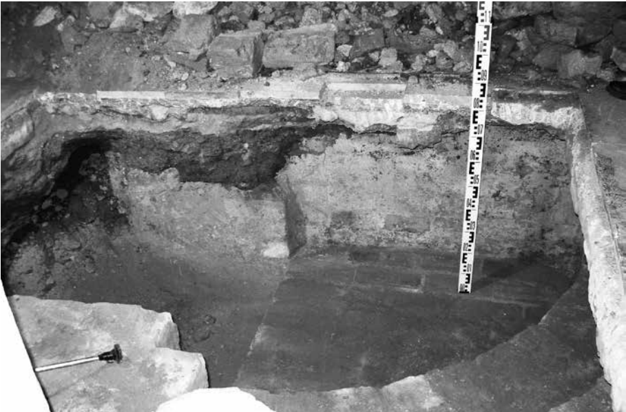
Fot. 4. Koźuchów, kościół farny, dawna kaplica mansjonarzy, ściana północna klatki schodowej na wysokości spocznika, element wtórny zamykający wejście do innych partii podziemi. Fot. J. Lewczuk
