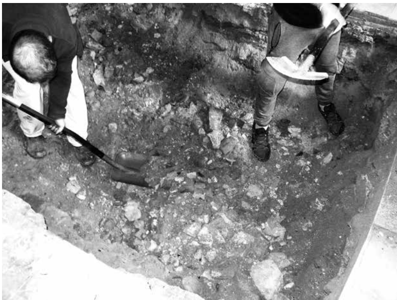
Fot. 13. Koźuchów, kościół farny, prezbiterium, eksploracja gruzowego zasypiska wnętrza wykopu. Fot. J. Lewczuk
