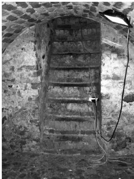
Fot. 7. Kozuchów, kościół farny, dawna kaplica mansjonarzy, widok na wnętrze uporządkowanej krypty wraz z prowadzącymi do niej schodami. Fot. J. Lewczuk
