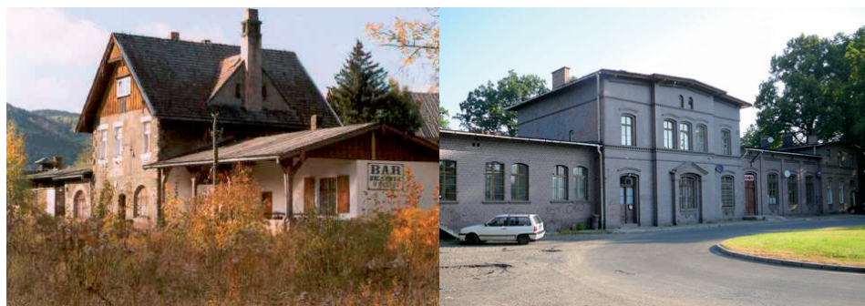
Rys. 16. Dawne budynki dworcowe w Radkowie (po lewej) i Mirsku (po prawej) zamienione na cele mieszkaniowo-użytkowe
