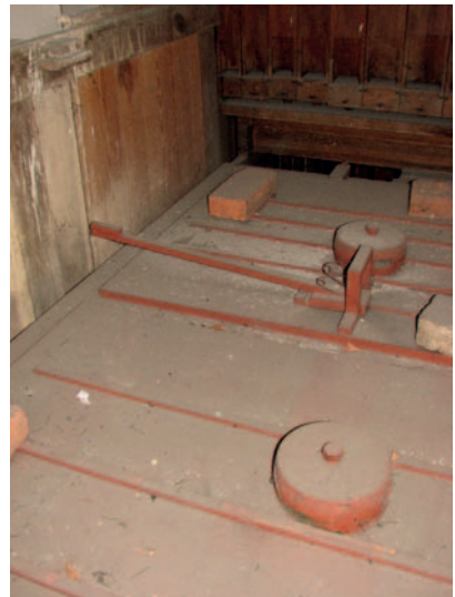
Fot. 19. Oryginalne żelwne ciężarki i dźwignia zaworu przepiętnia miecha
