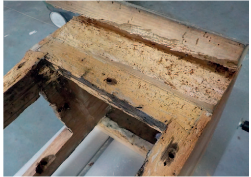
Zniszczenia fragmentu wiatrownicy rejestrowej – fot. A. Sutowicz
