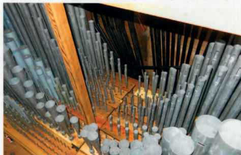
Piszczalki metalowe przed i po renowacji – fot. autor i A. Sutowicz
