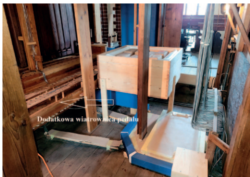
Miech skrzyniowy przed i po renowacji – fot. autor i A. Sutowicz
