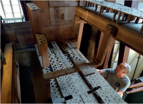
Wiatrownice II manualu po zdemontowaniu piszczałek – fot. A. Sutowicz
