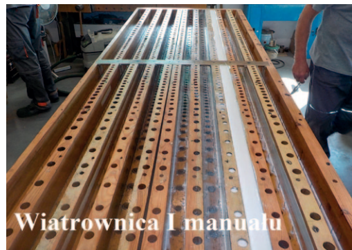
Wiatrownica I manualu po oczyszczeniu, uzupełnieniu ubytków i impregnacji – fot. A. Sutowicz
