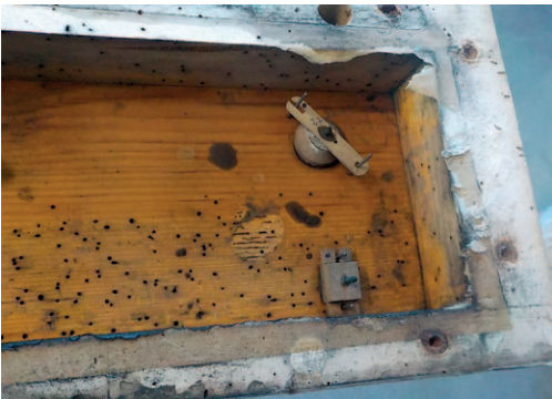
Ślady intensywnego żerowania szkodników (po oczyszczeniu z pyłu) – fot. A. Sutowicz
