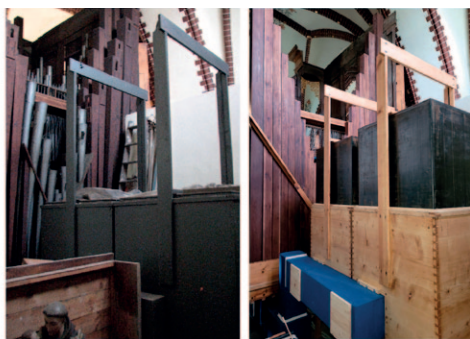
Miechy skrzyniowe przed i po renowacji
