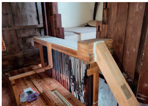
Wiatrownice II manualu (normalna i dodatkowa) w trakcie montażu – fot. A. Sutowicz
