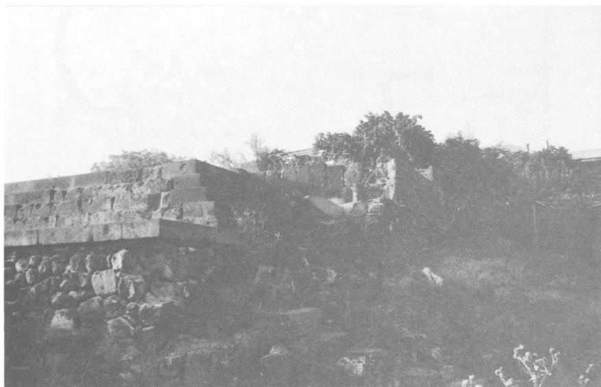
Il. 7. Bazylika. Pozostałości elewacji wschodniej, fot. D. Próchniak.
