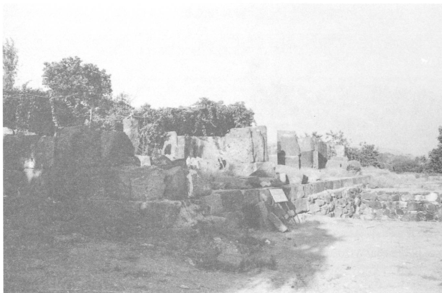
Il. 4. Bazylika. Pozostałości elewacji południowej, fot. D. Próchniak.
