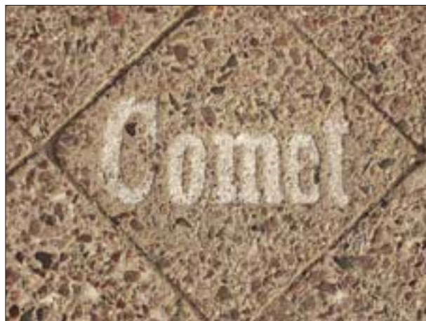
2. Betonowa płytko chodnikowa z cementowni Comet, zachowana przy ul. Felczaka, przy gmachu Urzędu Miejskiego, stan z 2006 r.
