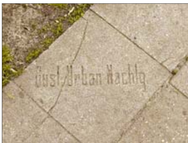
4. Betonowa płytka chodnikowa, Gust. Urban Nachlg, zachowana przy ul. św. Stanisława Kostki, stan z 2004 r. (źródło: www.sedina.pl ).
