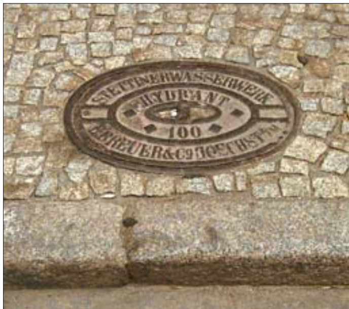
1. Żeliwna pokrywa zaworu, Szczecin, ul. Bohaterów Warszawy, stan z 2005 r.
