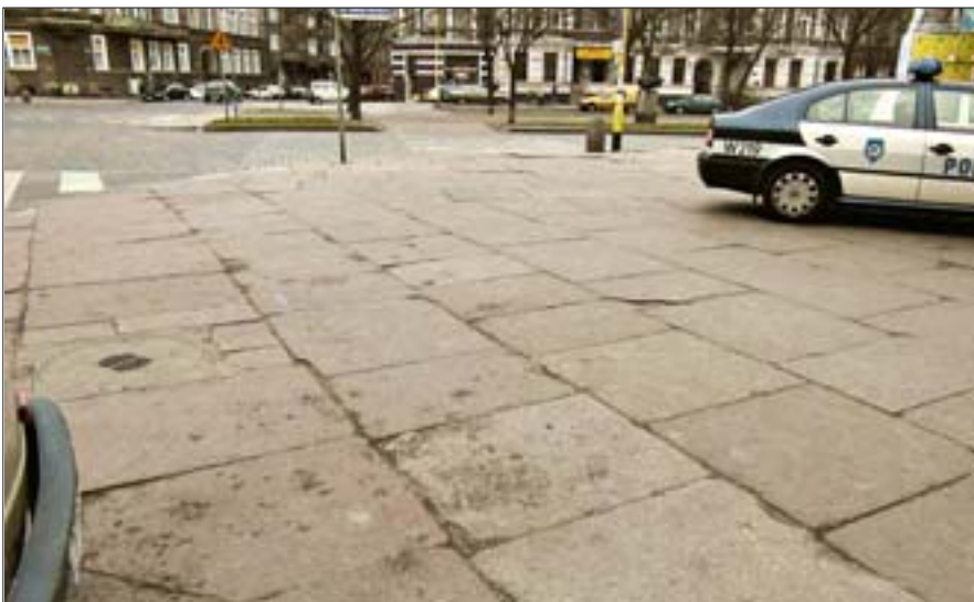
19. Szczecin, al. Jedności Narodowej/Mazurska, chodnik z nawierzchnią wykonaną z płyt granitowych, stan z 2004 r. 19. Szczecin, Jedności Narodowej/Mazurska Avenue, pavement with surface made of granite slabs, state in 2004.
