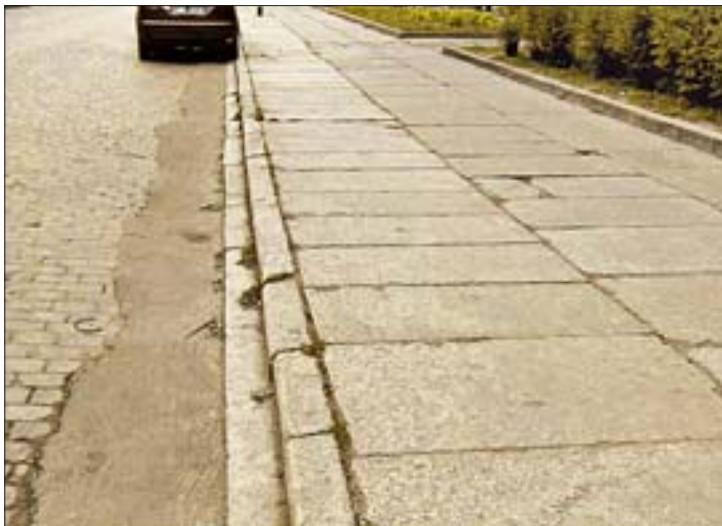
10. Szczecin, al. Jedności Narodowej, oryginalna nawierzchnia chodnika z płyt granitowych; stan z 2004 r.
