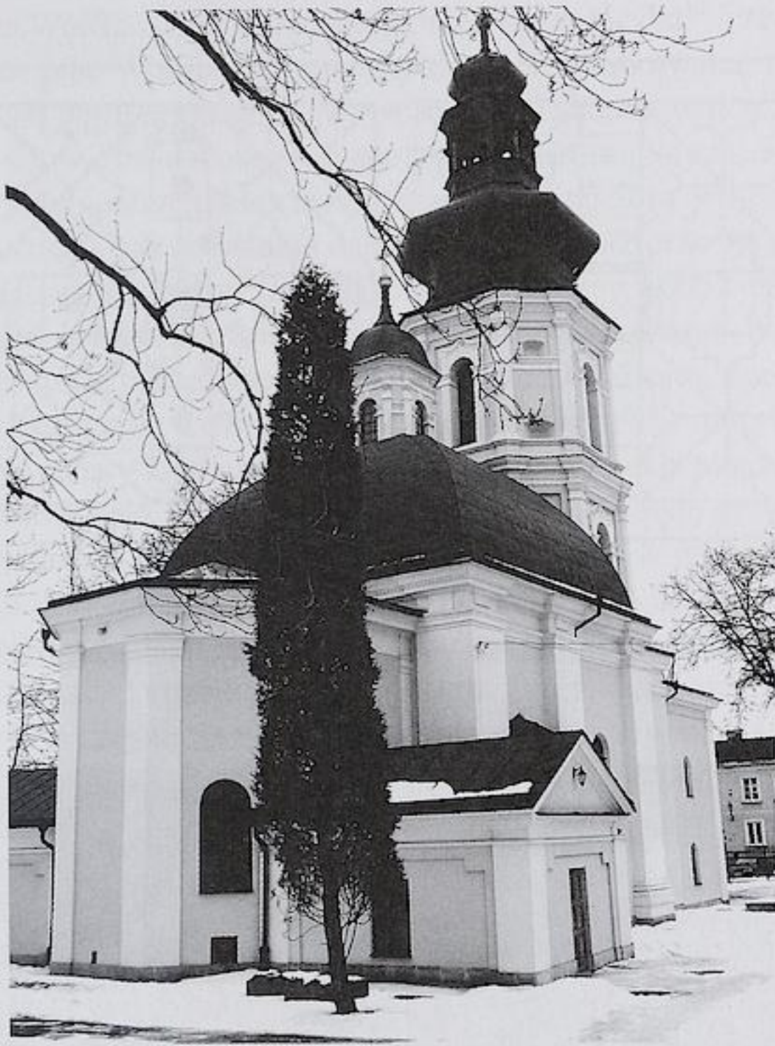
24. Zamość, cerkiew św. Mikołaja, widok od północnego-wschodu. Fot. autor, 2005
