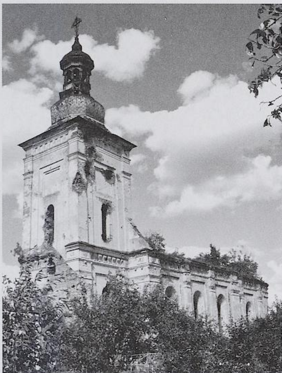
12. Leszniów, kościół bernardynów, widok ogólny od południowego-zachodu. Fot. autor, 2004
