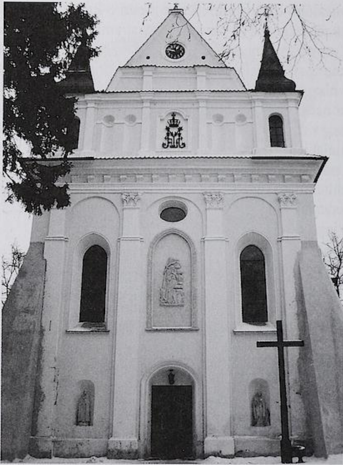
52. Łęczna, kościół par., fasada. Fot. autor, 2005
