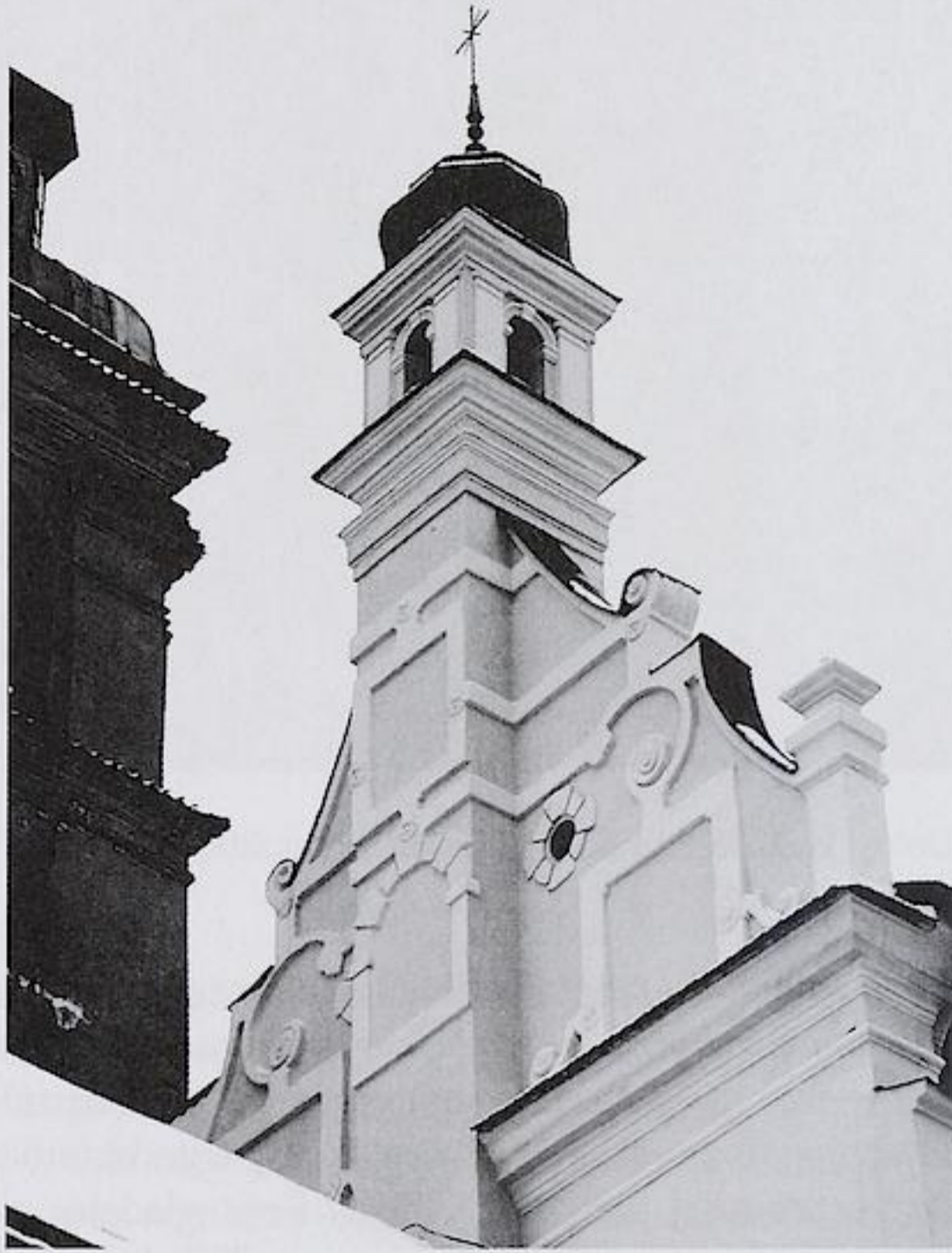
57. Lublin, kościół bernardynów, szczyt wschodni. Fot. autor, 2005
