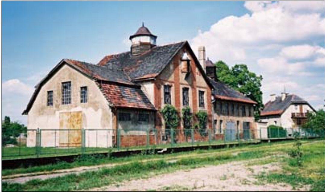
17. Gazownia w Krobi o nieco odmiennej architekturze, 2004 r. Fot. T. Palacz. 17. Gas-works in Krobia featuring slightly different architecture, 2004. Photo: T. Palacz.
