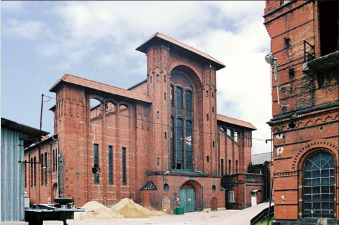
1. Kotłownia w zespole gazowni miejskiej w Poznaniu przy ul. Grobli, 2004 r. Fot. T. Palacz. 1. Boiler-room in the municipal gas-works complex in Grobli Street, Poznań, 2004. Photo: T. Palacz.
