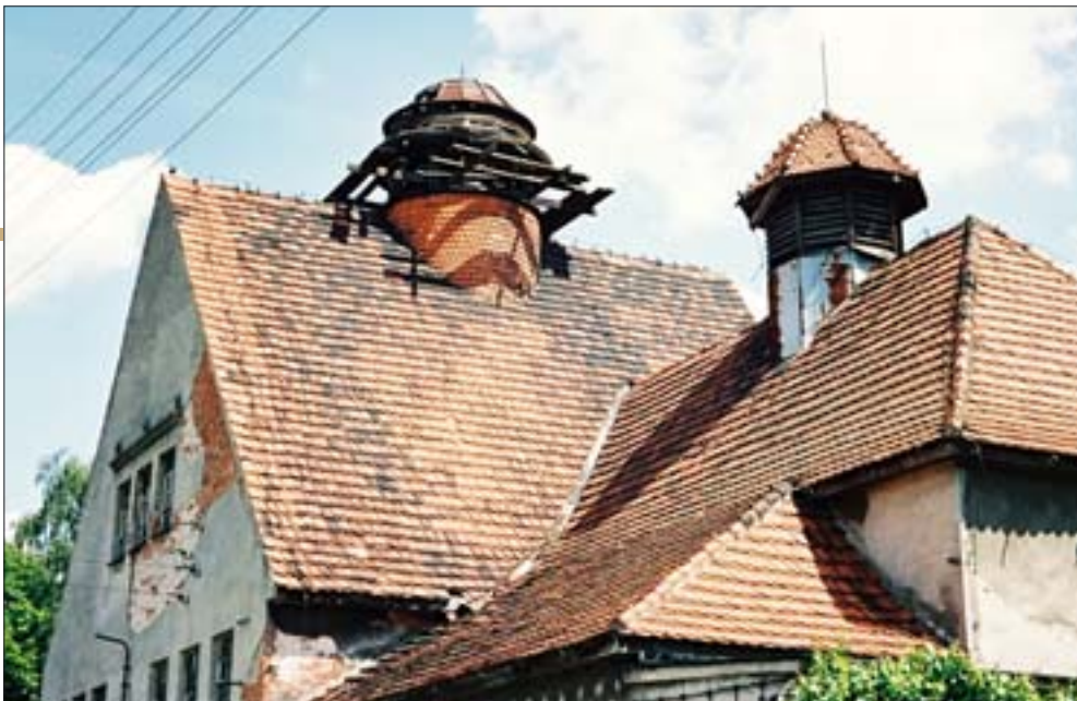
18. Gazownia w Miejskiej Górcie, dachy budynków o kształtach rzadko spotykanych w Wielkopolsce, 2004 r. Fot. T. Palacz. 18. Gas-works in Miejska Górka, roofs with shapes rarely encountered in Greater Poland, 2004. Photo: T. Palacz.
