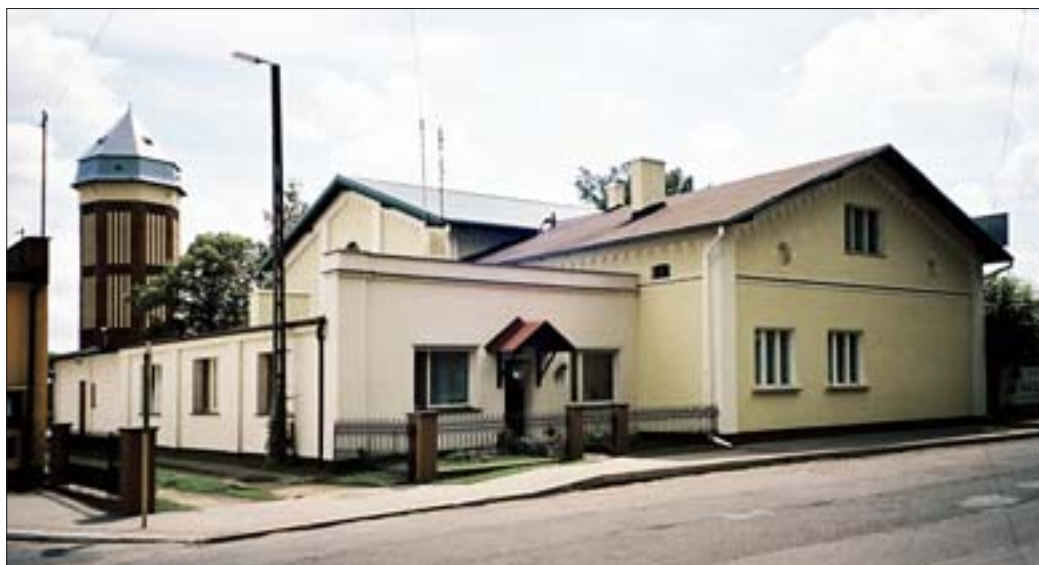
21. Gazownia w Nowym Tomysłu, obecnie rozdzielnia gazu ziemnego, 2004 r. Fot. T. Palacz.
