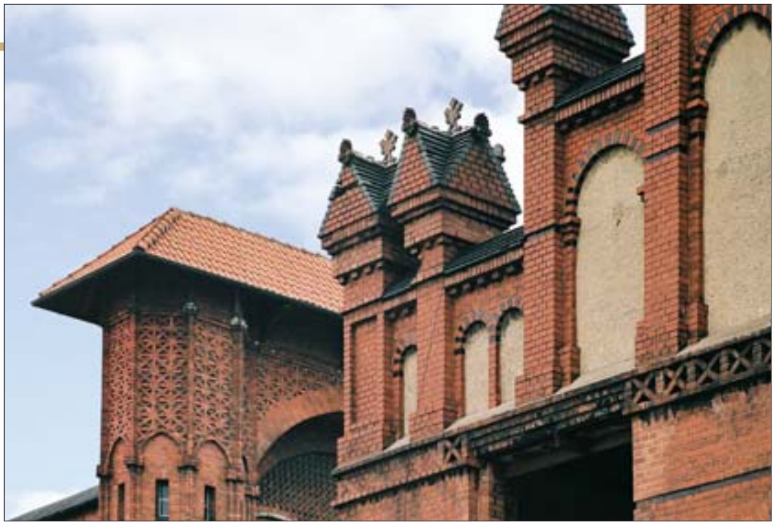
8. Piękno detalu architektonicznego, gazownia w Poznaniu, 2004 r. Fot. T. Palacz. 8. Beauty of the architectural detail, gas-works in Poznań, 2004. Photo: T. Palacz.
