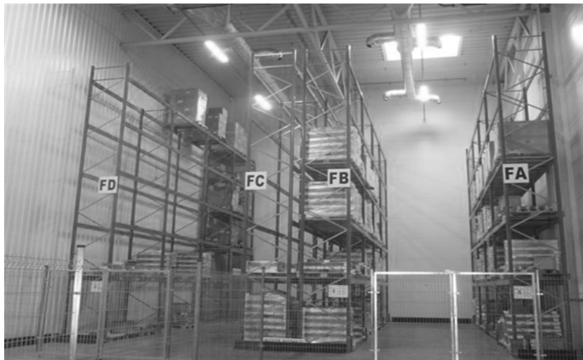
Rys. 1. Strefy przyjęcia i wydania towaru w magazynie farmaceutycznym z wykorzystaniem siatek oddzielających
