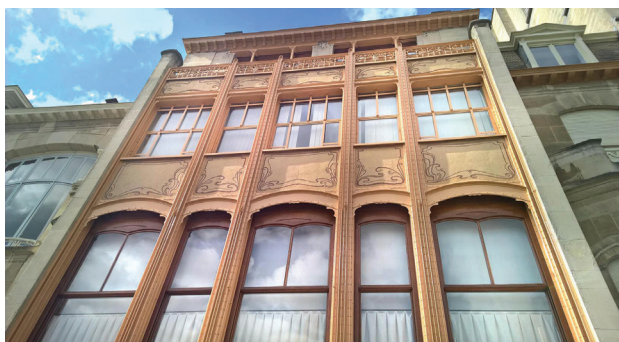
Il. 2. Żelazna konstrukcja i duże okna w oficjalnej części Hôtel van Eetvelde (fot. B. Widera)
