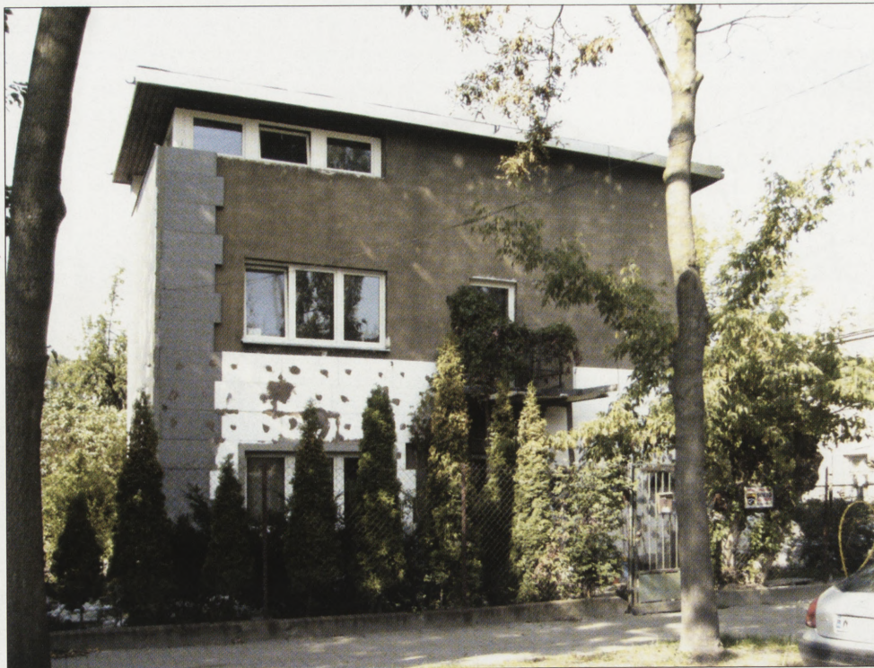
24. Budynek jednorodzinny z lat 30. XX w. przy ul. Karwińskiej 15 w trakcie ocieplania elewacji, 2006 r. 24. Single-family building erected in the 1930s at 15 Karwińska Street, with insulation of the facade underway, 2006.
