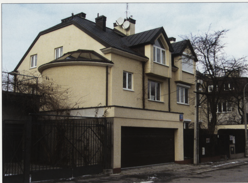
25. Dom jednorodzinny z lat 30. XX w. przy ul. Płatowcowej 17 po przebudowie w latach 90. XX w. na budynek bliźniaczy, 2009 r. 25. Single-family house built in the 1930s at 17 Płatowcowa Street, converted into a semi-detached building in the 1990s, 2009.
