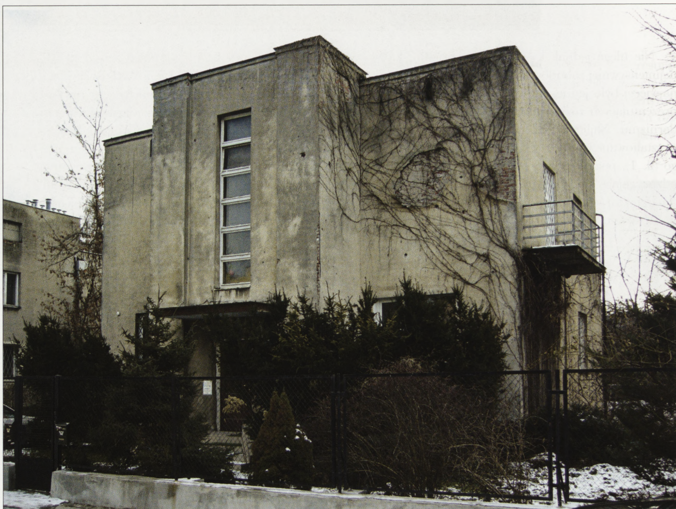
16. Budynek jednorodzinny przy ul. Gimnastycznej 5, 2006 r. 16. Single-family building at 5 Gimnastyczna Street, 2006.
