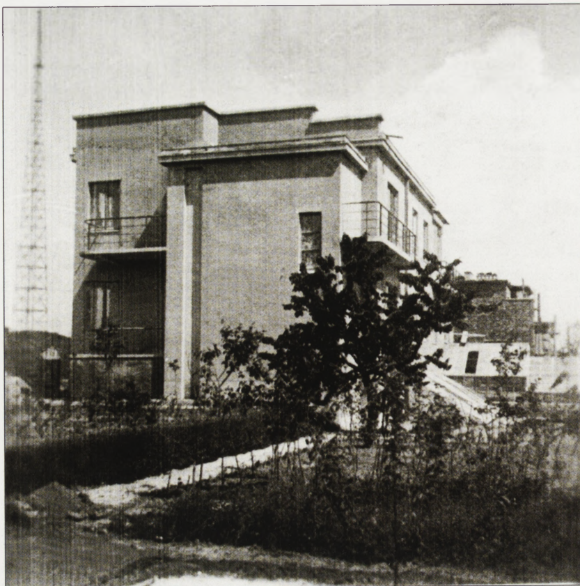
9. Osiedle Oficerskiej Spółdzielni Budowlano-Mieszkaniowej „Dom”, budynek bliźniaczy przy ul. Olimpijskiej 31/33, proj. A. Buraczewski (1934 r.), 1938 r. Zbiory prywatne.
