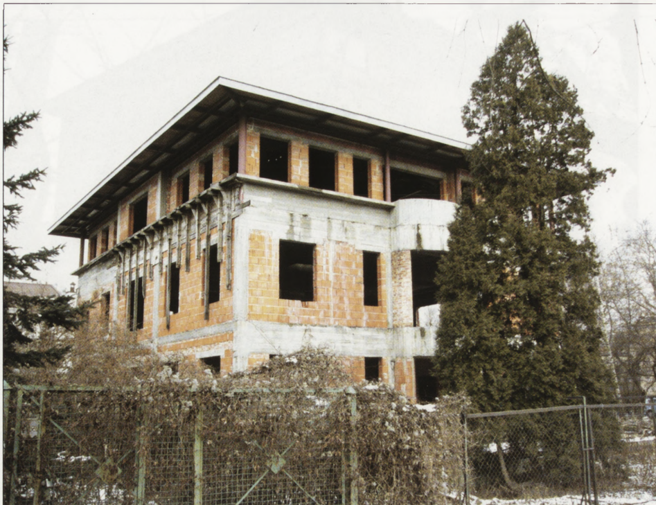
28. Trzykondygnacyjny budynek wielorodzinny zbudowany przy ul. Raclawickiej 102 na miejscu wyburzonego domu jednorodzinnego z lat 30. XX w., 2009 r.
