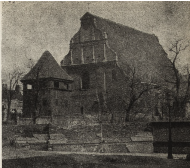
Ryc. 90. Poznań — kościół św. Wojciecha. Na pierwszym planie drewniana dzwonnica po konserwacji.
