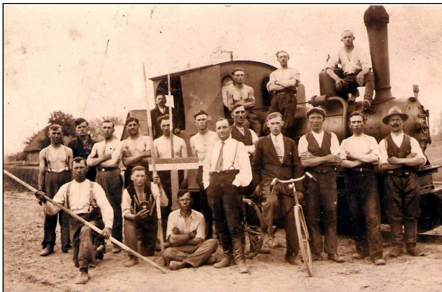
Fot. 5. Budowa kolei Herby–Inowrocław, Bydgoszcz–Gdynia Wieś Ochraniew pod Zduńską Wolą – 1932 r. Kazimierz Sadowski na rowerze Źródło: ze zbiorów Heleny Zalewskiej
