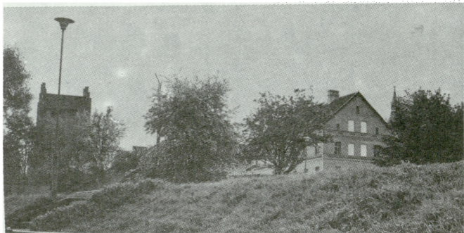
8. Usytuowanie odbudowanego Domu „Gazety Olsztyńskiej” w stosunku do Wysokiej Bramy. Zdjęcie od strony fosy oddzielającej gotycki zamek
