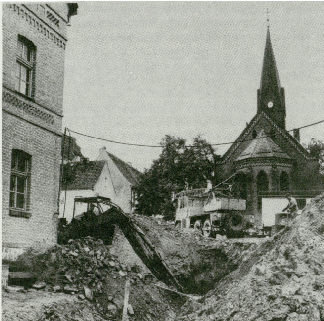
11. Na teren placu Gen. K. Świerczewskiego ponownie wjeżdżają koparki. Z lewej strony fragment odbudowanego Domu Gazety
