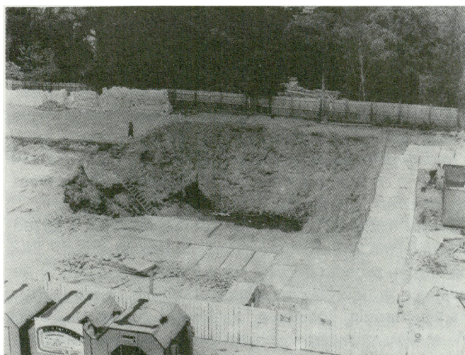
7. Plac Gen. K. Świerczewskiego — wykop pod Dom „Gazety Olsztyńskiej”. Widok ogólny z Wysokiej Bramy (fot. R. Merchel, 1988)
