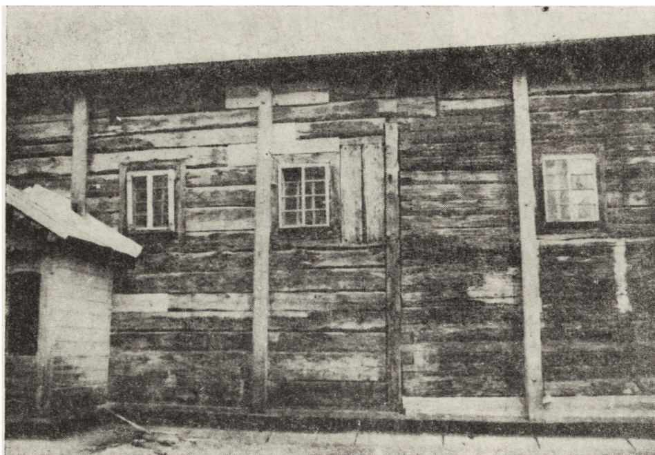
8. Hanna, fragmenty ścian nawy i babińca od strony północno-wschodniej – stan w czasie prac konserwatorskich, po zdjęciu oszalowania (fot. ze zbiorów ks. M. Pyrki)
