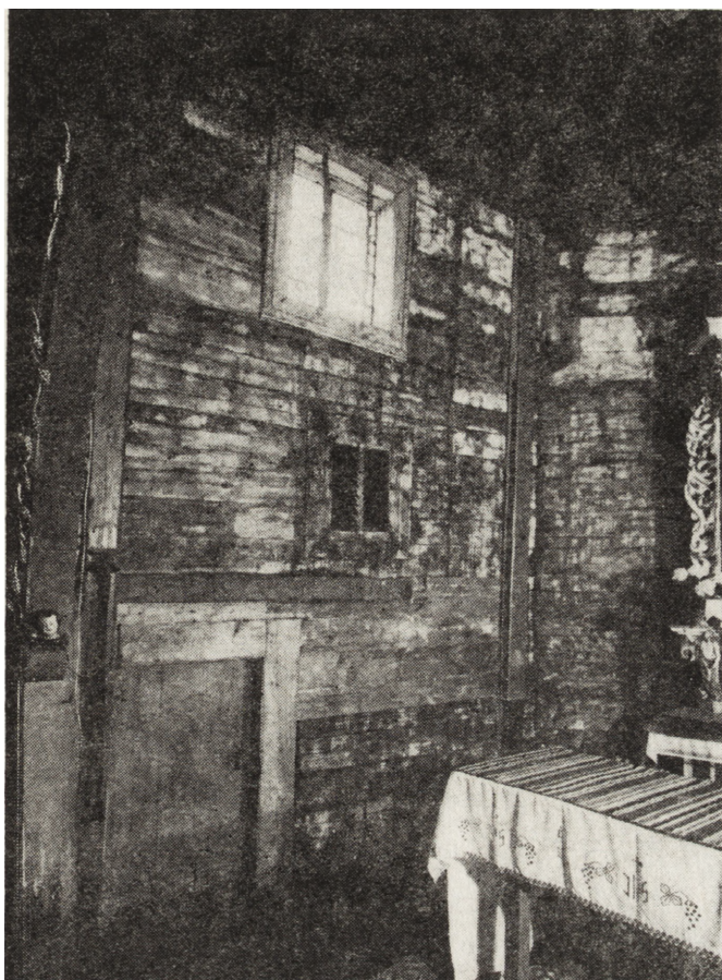
6. Hanna, wewnątrz, widok na ścianę północno-zachodnią prezbiterium – stan w czasie prac konserwatorskich, po zdjęciu malowanych płócien (fot. J. Langda, 1977)
