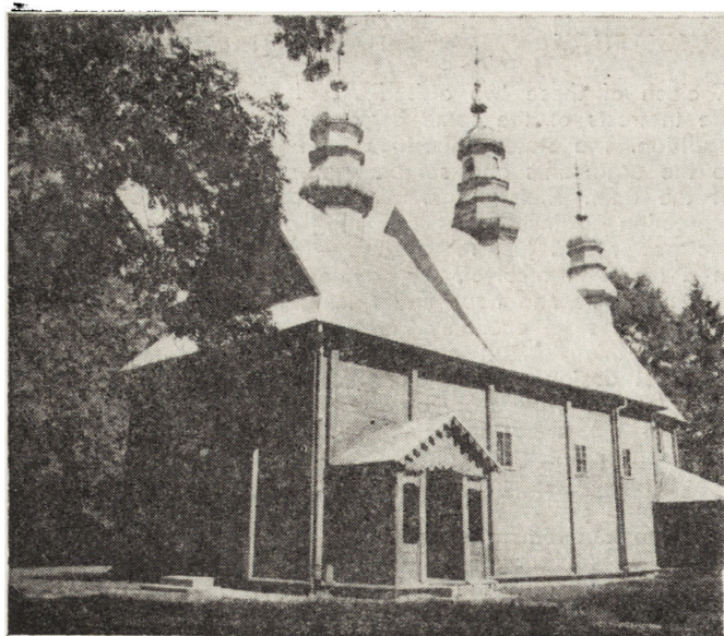
1. Hanna, dawna unicka cerkiew parafialna p.w. Św. Piotra i Pawła; widok na elewację frontową i boczną (orientowana na północny wschód) – stan przed pracami konserwatorskimi (fot. R. Brykowski, 1976)
