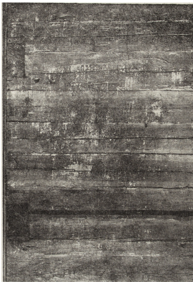
10. Hanna, fragment południowo-wschodniej ściany nawy ze śladami po konstrukcji chóru muzycznego (fot. J. Langda, 1977)
