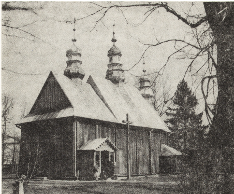
12. Hanna, widok na elewację frontową i boczną – stan po pracach konserwatorskich (fot. B. Martyniuk, 1985)
