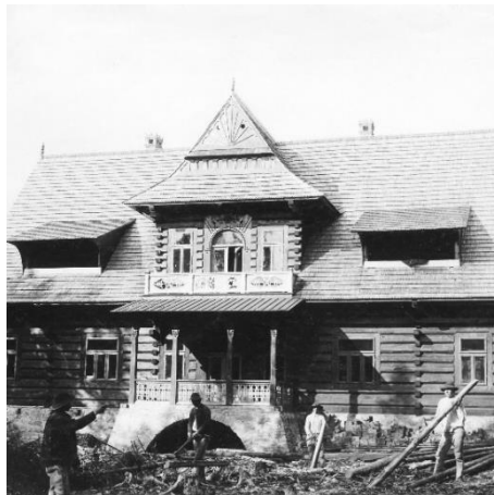
II. 2. Willa Oksza w budowie.
