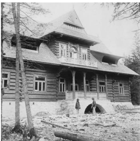
II. 3. Willa Oksza w budowie.
