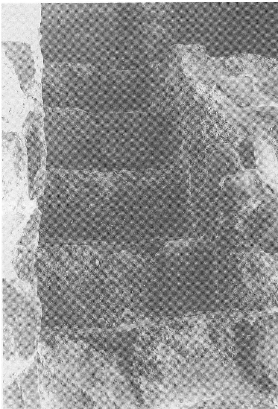
Ryc.10. (H) Kamienne schody wieży
