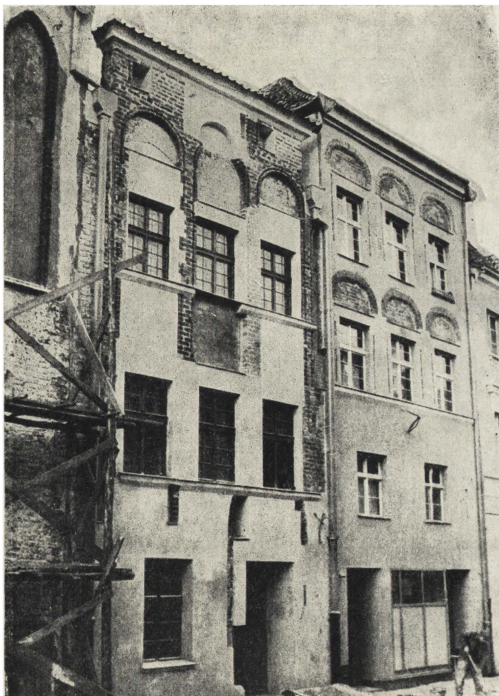
Ryc. 8. Toruń, kamienice przy ul. Kopernika 17 i 19. (fot. M. Arszyński)
