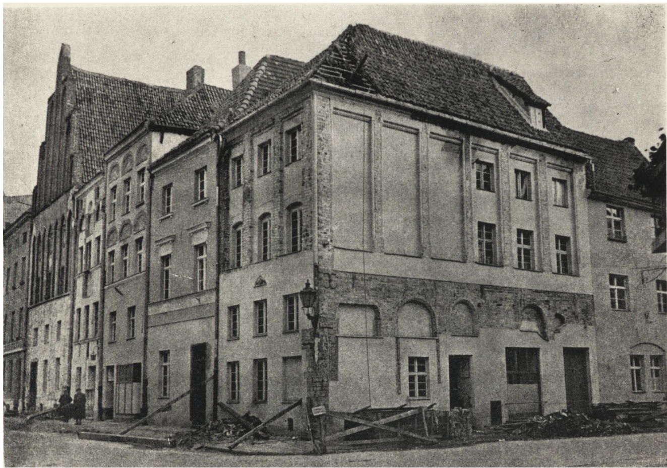
Ryc. 7. Toruń, kamienice przy ul. Kopernika w trakcie prac remontowo-konserwatorskich 1960 r. (fot. PKZ)
