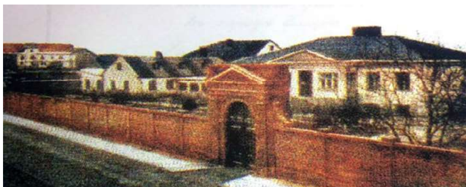
Dworek przy ul. Dobrzyńskiej, na którego zrębach powstał Kościół i Klasztor Mariawitów, zdjęcie archiwalne; źródło: „Mariawita” 1962 r., nr 3, s. 26
