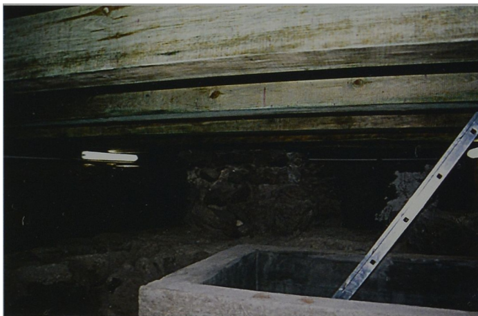
Fot. 4 Giecz- nowopostawły skansen archeologiczny wewnątrz romańskiego kościoła p.w. Wniebowzięcia NMP i św. Mikołaja; relikty fundamentu południowo- zachodniego narożnika nawy starszego kościoła, widok od strony północno- wschodniej (fot. T. Krysztofiak) Photo 4 Giecz- neuentstandenes archäologisches Freilichtmuseum im Innern der romanischen Kirche der Mariä Himmelfahrt und St. Nikolaus; Relikte des Fundaments des südwestlichen Schiffs der älteren Kirche (Photo T. Krysztofiak)
