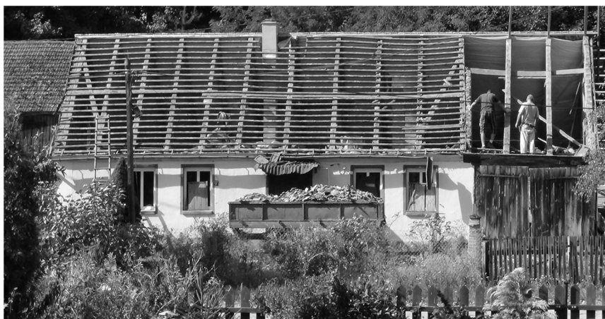
Fotografia 3. Budynek przed remontem.
