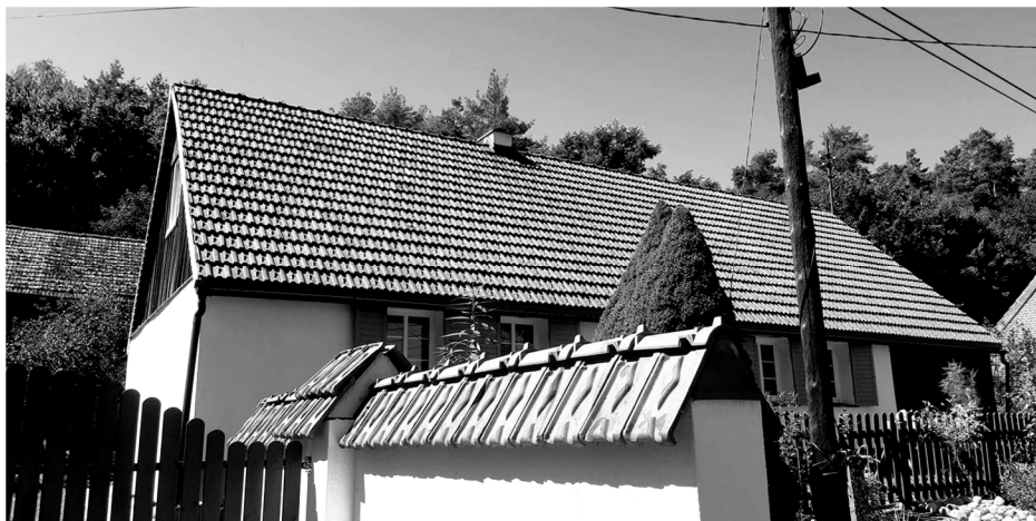
Fotografia 5. Zastosowanie ręcznie formowanej dachówki.
