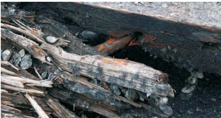
Ryc. 3. Widok na podstawę jednej z klepek, z której wychodzi metalowy trzpień łączący ten element z zachowanym fragmentem jednej z uszkodzonych klepek, fot. A. Ostasz Fig. 3. A view of the base of one of planks, from which protrudes a metal pin that connects the element with a preserved fragment of one of the damaged planks, photo A. Ostasz
