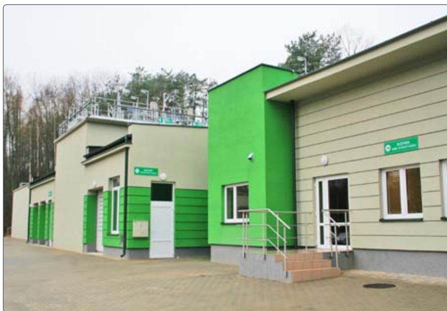
Nalęczów. Oczyszczalnia ścieków
