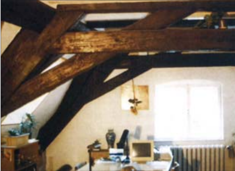
6. Kamienica przy ul. Szerokiej 16 w Toruniu. Więźba o stolcach leżących jako element wystroju pomieszczenia biurowego. Fot. M.R. Gogolin.
