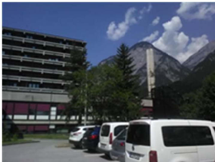
Zdj. 15. Bibliothekszentrum West. Fot. E. Kotuła.
