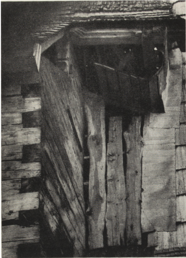
12. Haczów. Dawny kościół par. Fragment gzymsu z dawnej elewacji zach., znajdujący się obecnie pomiędzy zach. ścianą kościoła a wieżą od strony pn. (fot. Jerzy Langda 1962, zbiory IS PAN)
