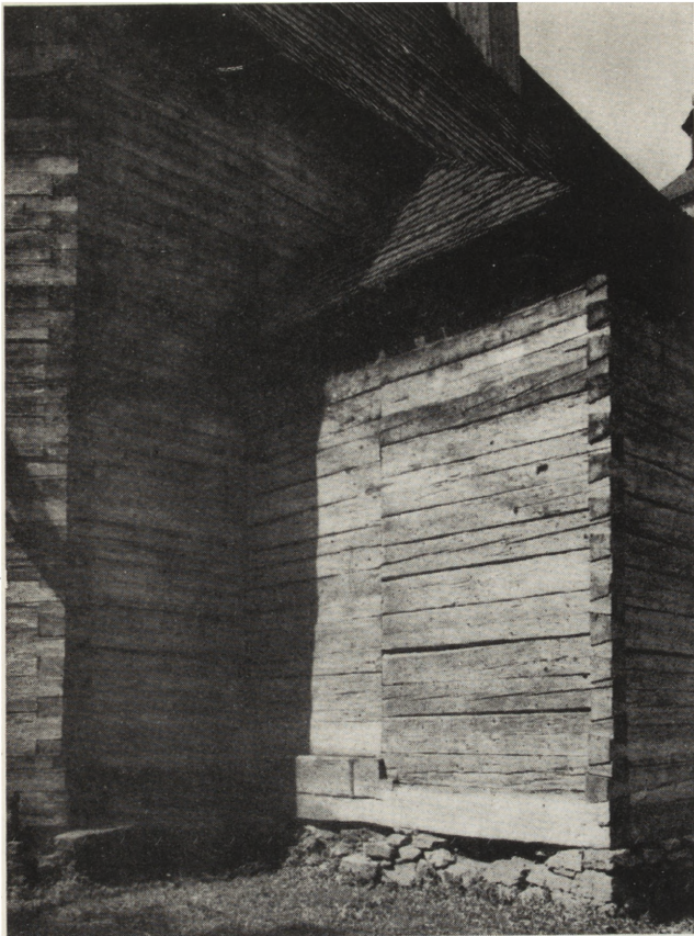
7. Haczów. Dawny kościół par. Wschodnia ściana zakrystii — po zdjęciu oszalowania. Stan z 1962 r. (fot. Jerzy Langda, zbiory IS PAN)
