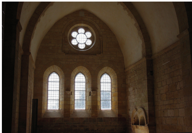
Il. 2. Ściana szczytowa prezbiterium kościoła opactwa Noirlac, około 1140 (fot. Patrick; www.flickr.com, data dostępu: 14.04.2015) Fig. 2. Presbytery gable wall of the church in Noirlac abbey, about 1140 (photo by Patrick; www.flickr.com, accessed: 14.04.2015)
