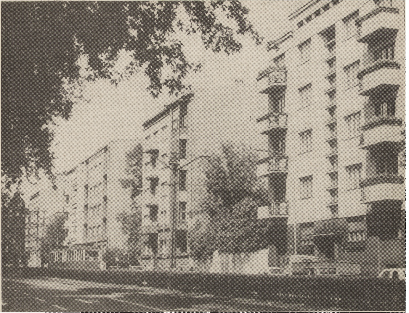
9. Łódź, komfortowe kamienice czynszowe z okresu międzywojennego przy al. Kościuszki w odcinku pomiędzy ulicami A. Struga i Zamenhofska 9 (fot. T. Kacznarek, 1979 r.)
