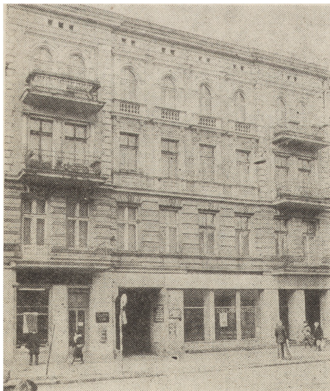
4. Łódź, kamienica czynszowa przy ul. Piotrkowskiej 109, proj. G. Landau-Gutenteger, 1894 r., widok od strony ulicy i od strony podwórza ukazujący długie oficyny integralnie połączone z budynkiem frontowym (fot. Z. Jarzyński, 1979 r.)
