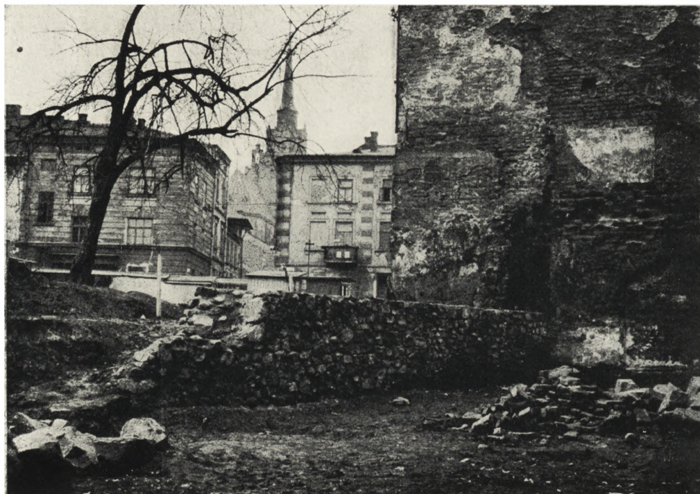
Ryc. 25. Tarnów, plac Rybny, odkopany i uzupełniony w roku 1960 fragment muru obronnego z XIV wieku. (fot. T. Chrzanowski)
