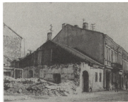
5. Kielce, dom przy ul. Armii Czerwonej 9, częściowo rozebrany w 1985 r. (Fot. P. Rosiński)
