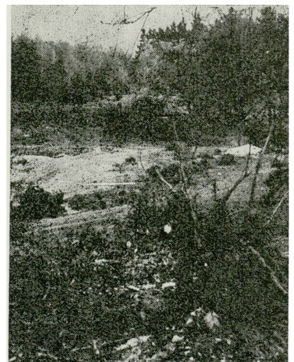
1. Komierowo, ośrodek wypoczynkowy PGR, prace rekonstrukcyjne przy budowie stawów parkowych (fot. A. Płażewska)
