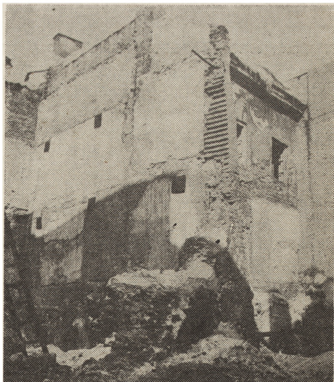
8. Lublin, oficyny budynków przy ul. Grodzkiej 3 i 5; prace budowlano-konserwatorskie prowadzone przez PP PKZ — Oddział w Lublinie, stan w marcu 1980 r.
