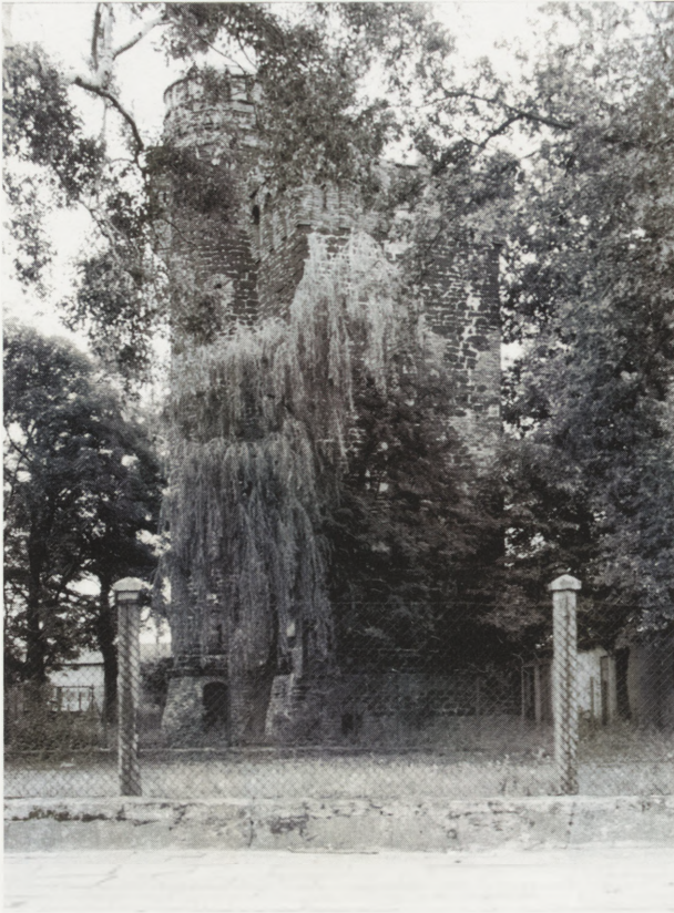
10. „Wieża” gen. Klickiego to fragment nieukończonyj budowli (tzw. zbrojowni)
