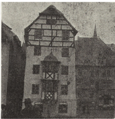
1. Cheb, Czechy zachodnie, zrekonstruowany i zmodernizowany spichrz gotycki w rynku
