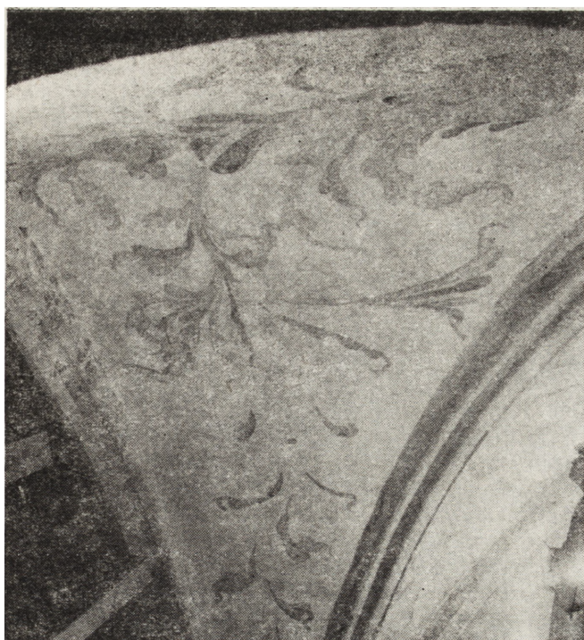
7. Sklepienie południowej nawy kościoła Św. Marcina w Jaworze, wysklepek w trakcie punktowania – faza II 7. The vaulting of the south nave of St Martin's church in Jawor, arching during the pointing – phase II
