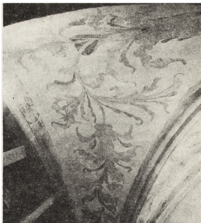
8. Sklepienie południowej nawy kościoła Św. Marcina w Jaworze, wysklepek po zakończeniu punktowania – faza III 8. The vaulting of the south nave of St Martin's church in Jawor, arching after the completion of the pointing – phase III
