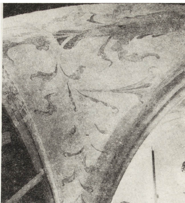
6. Sklepienie południowej nawy kościoła Św. Marcina w Jaworze, wysklepek w trakcie punktowania – faza I
