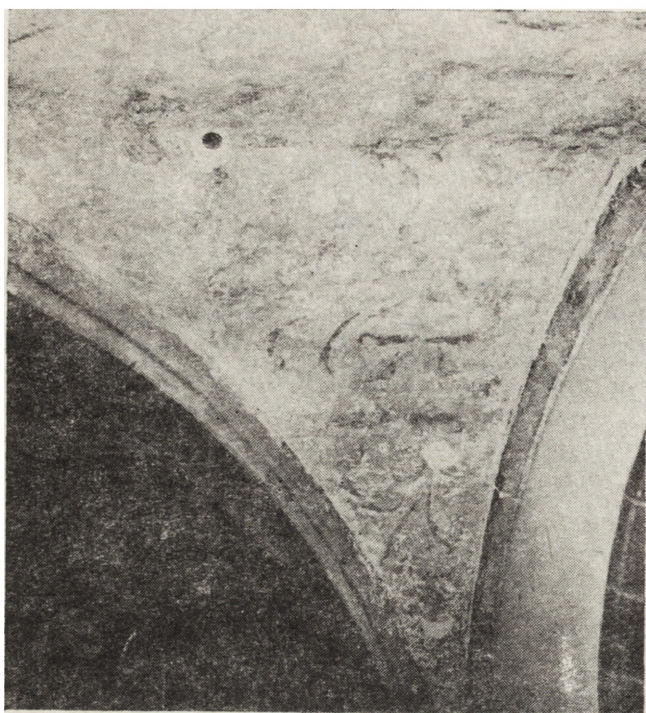
5. Sklepienie południowej nawy kościoła Św. Marcina w Jaworze, wysklepek trzeciego przęsła po założeniu kitów drobnoziarnistych
