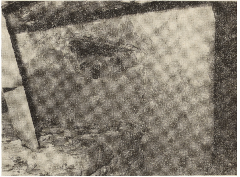
4. Wiśnicz Nowy, północna budowla bramna: A — portal zewnętrzny oraz fragment muru osłaniającego szyję wjazdową i wzmocniającego wal ziemny; B — zamurowana strzelnica kluczowa i fragment muru obronnego (fot. J. Gajdziński)
