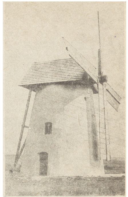
11. Wiatrak w Krasocinie po przeprowadzeniu prac konserwatorskich 1980 r. (fot. A. Szura)
