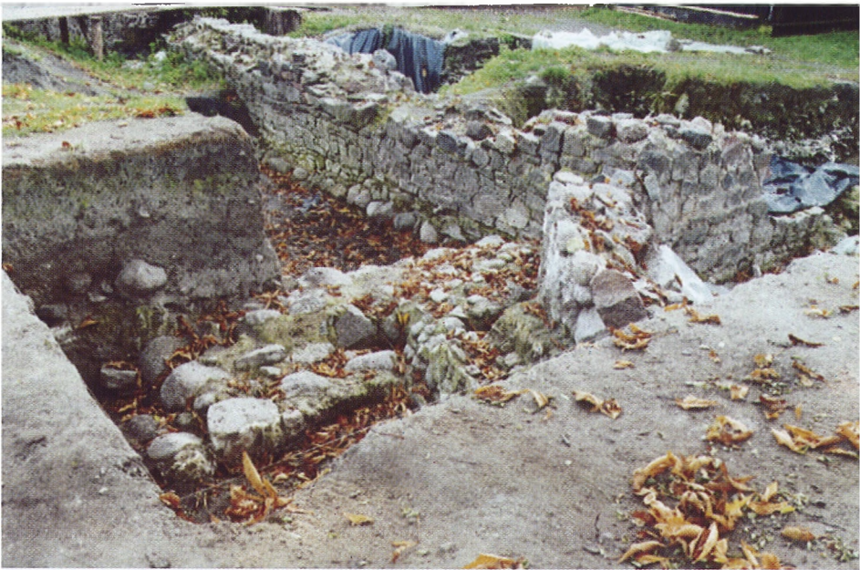
Fot. 3. Naroże północno-zachodnie kościoła, fundament „nawy” i styk okrągłej wieży z korpusem kościoła Fot. A. Ziółkowski
