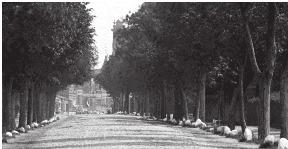
11. Ulica Lęborska w stronę centrum. Po prawej widoczny wysoki, ceglany mur cmentarza ewangelickiego, 1904 r. 83
