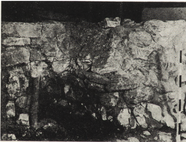
12. Kościółek, wnętrze nawy, płyta wyznaczająca narożnik północny absydy podparta palikami (fot. E. Buczek)
