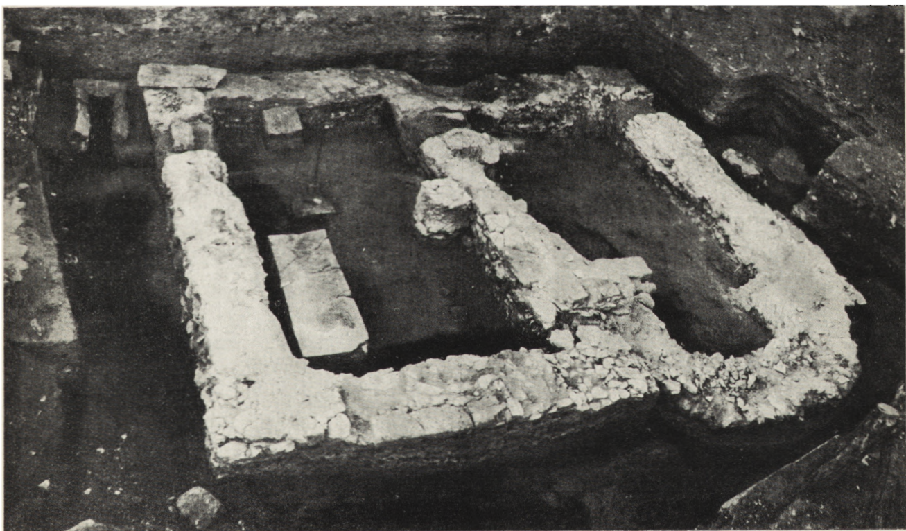
2. Mury fundamentowe kościółka wraz z kaplicą grobową (fot. E. Buczek)
