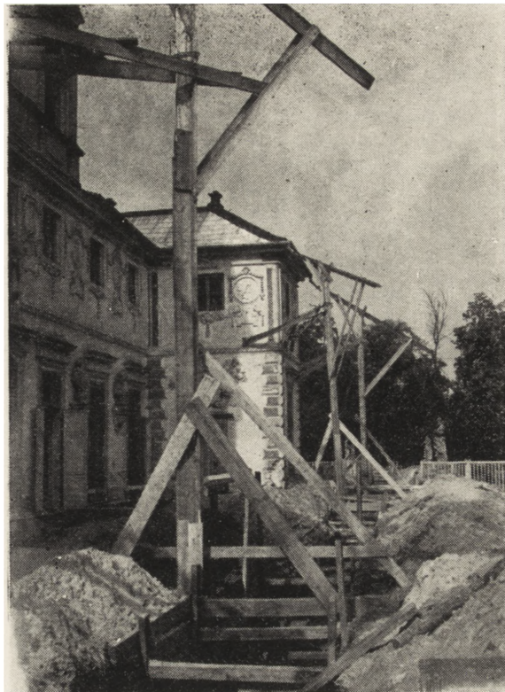
Ryc. 159. Wilanów — budowa tras instalacji centralnego ogrzewania i wodno-kanalizacyjnych.
