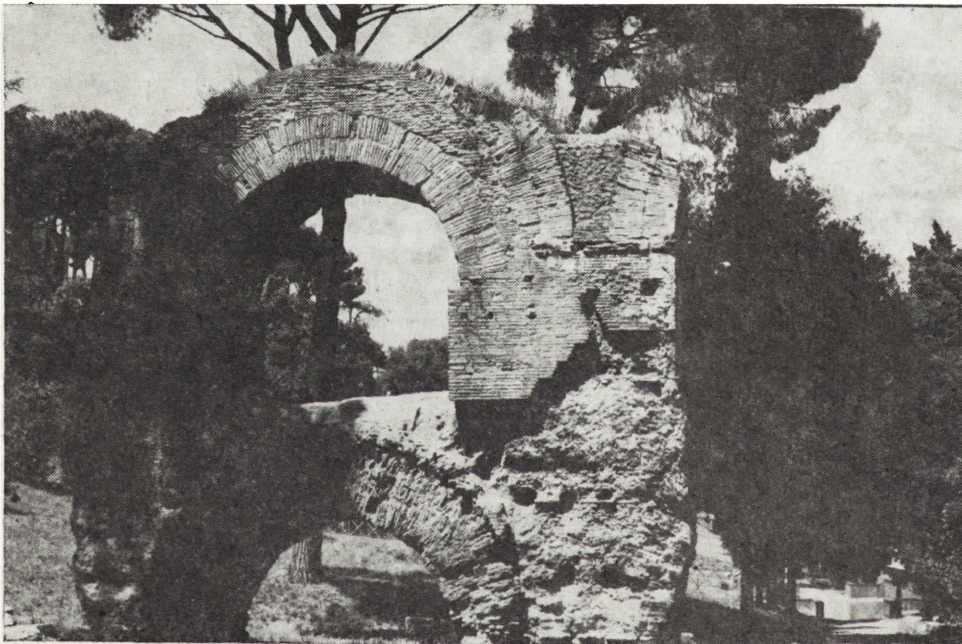
12. Ruiny akweduktu doprowadzającego wodę na Palatyn; widoczne ubytki ceglanego oblicowania
