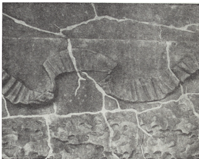
8. Kolumna Trajana, fragment powierzchni marmuru po wypełnieniu pęknięć zaprawą wapienną (przed scaleniem kolorystycznym)
