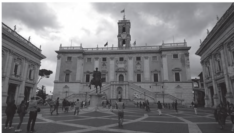
Fot. 2. Oryginalna nawierzchnia z bazaltowych sampietrini i trawertynu na placu na Kapitolu w Rzymie, fot. S. Wróblewski 2017
