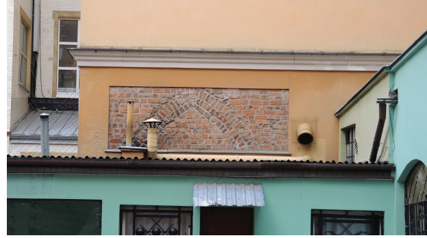
Il. 2. Przykład fragmentarycznego eksponowania średniowiecznych elementów budynku – Wrocław, ul. Więzienna (fot. R. Zapłata, 2015)
