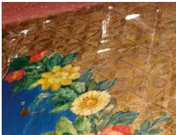
8. Fragment szafy ołtarzowej, widoczne ubytki złoceń. 8. Fragment of the altar, visible gaps of the gilding.
