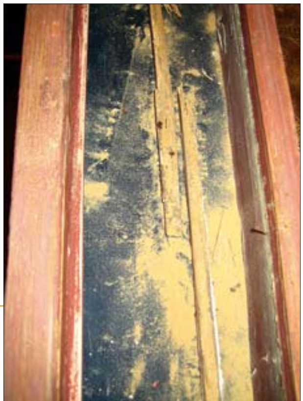
7. Fragment szafy ołtarzowej, widoczny zły stan zachowania drewna listew przytrzymujących ażurowy ornament. 7. Fragment of the altar, with visible unsatisfactory state of the preservation of the wooden strips upholding the latticework ornament.
