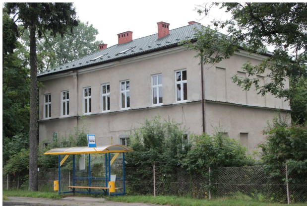
Fot. 5. Gorlice, budynek „Ruskiej Bursy”
