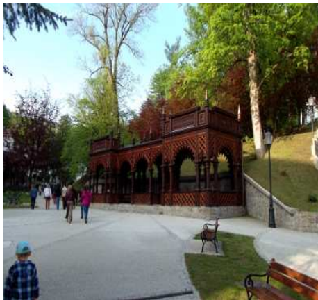
Fot. 3. Szczawnica. Nowa czerpnia wody mineralnej fot. W. Wójcikowski (2013)
